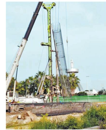
金山大道提升改造项目桥梁桩基钢筋笼吊装。(市城乡建设局供图)
