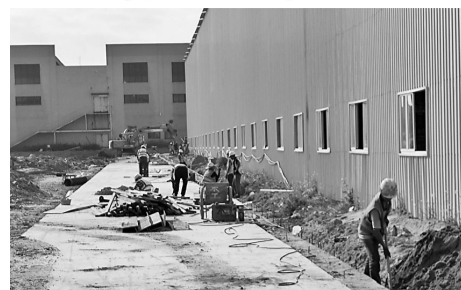
福州机场第二高速A5项目建设现场。(项目方供图)
