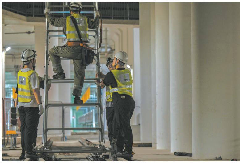
接触网工爬上三四米高的梯车开始巡检。本报记者 陈暖霞
