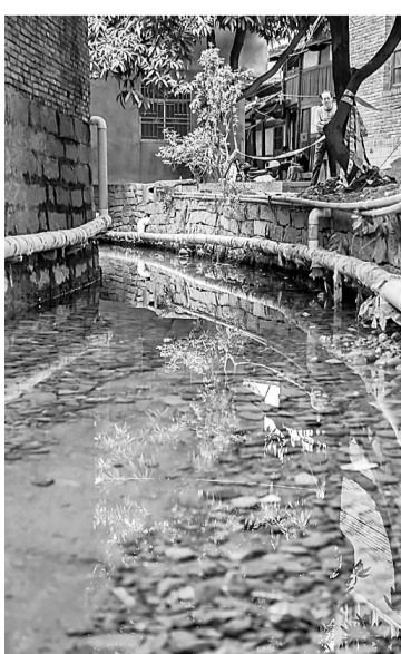
已经完成清淤的胪厦溪示范段。 本报记者 陈暖摄
