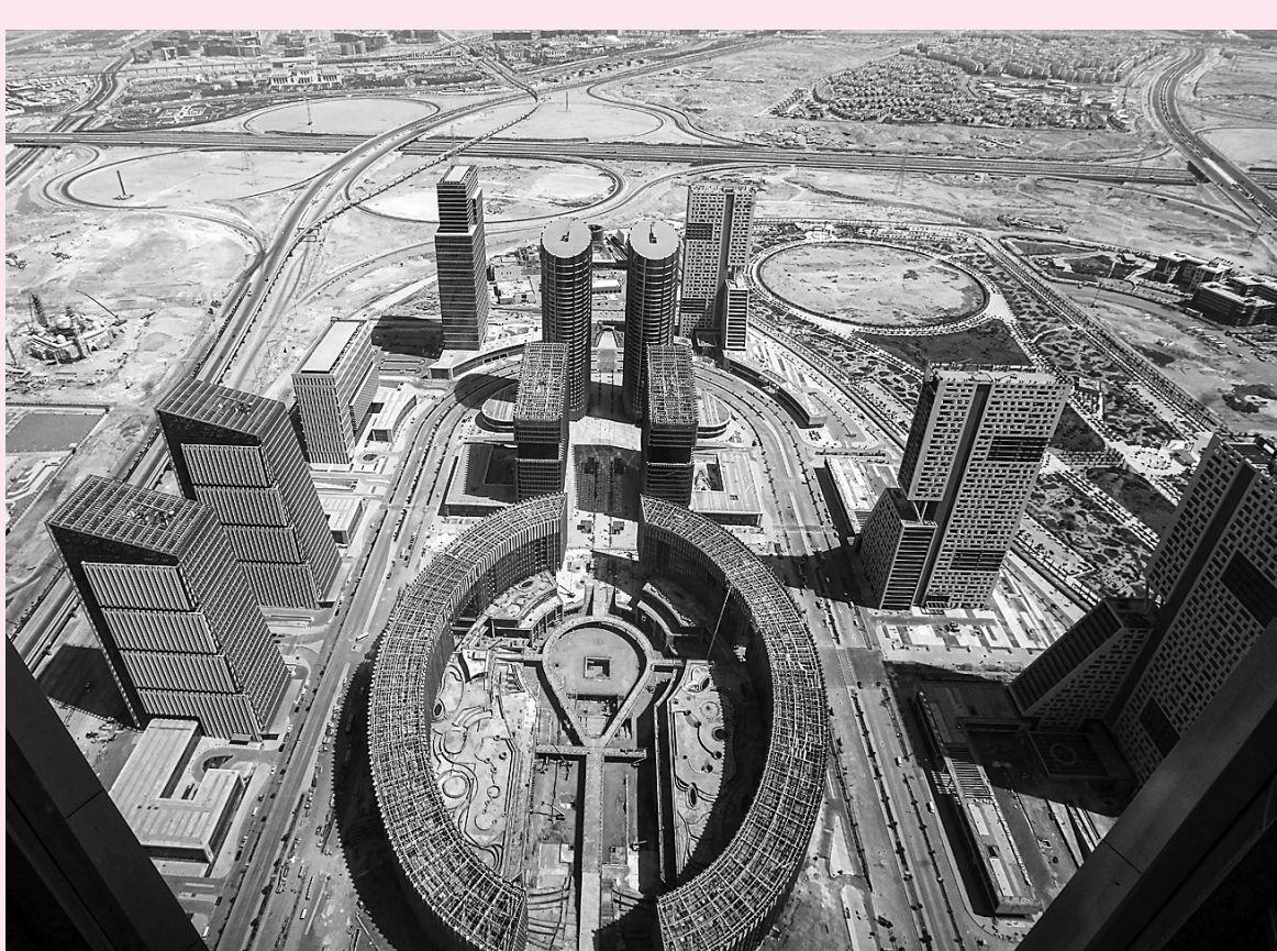
这是2023年9月11日在埃及开罗以东拍摄的建设中的新行政首都中央商务区。埃及经济研究中心研究员穆斯塔法·穆罕默德对共建“一带一路”的未来则有着更具象的畅想。
