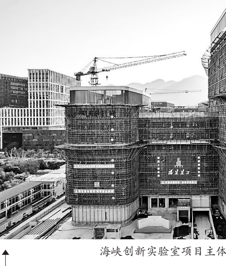
海峡创新实验室项目主体已封顶。本报记者 林双伟摄
