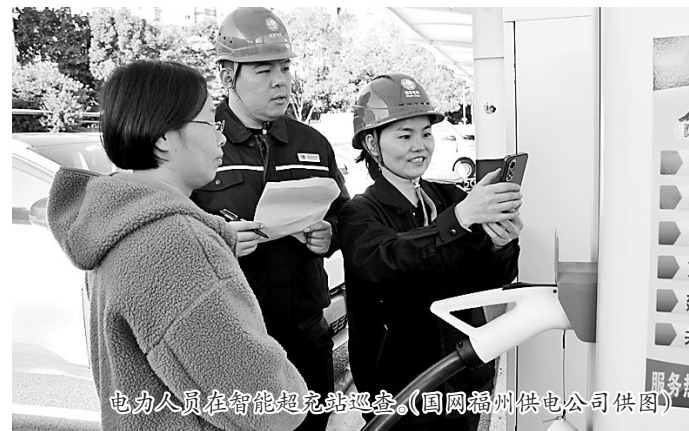
电力人员在智能充电桩巡查。(国网福州供电公司供图)
