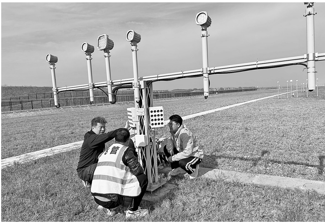
姜自壮(左一)带领工作人员在机场灯杆上安装超音波驱鸟器。(受访者供图)
