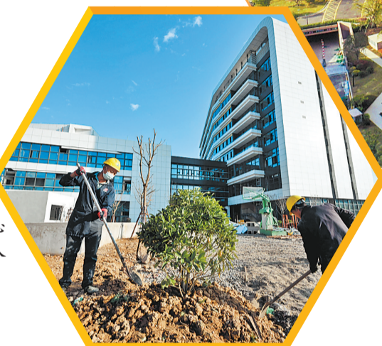
闽侯县上街中心卫生院扩建项目进入收尾阶段。
