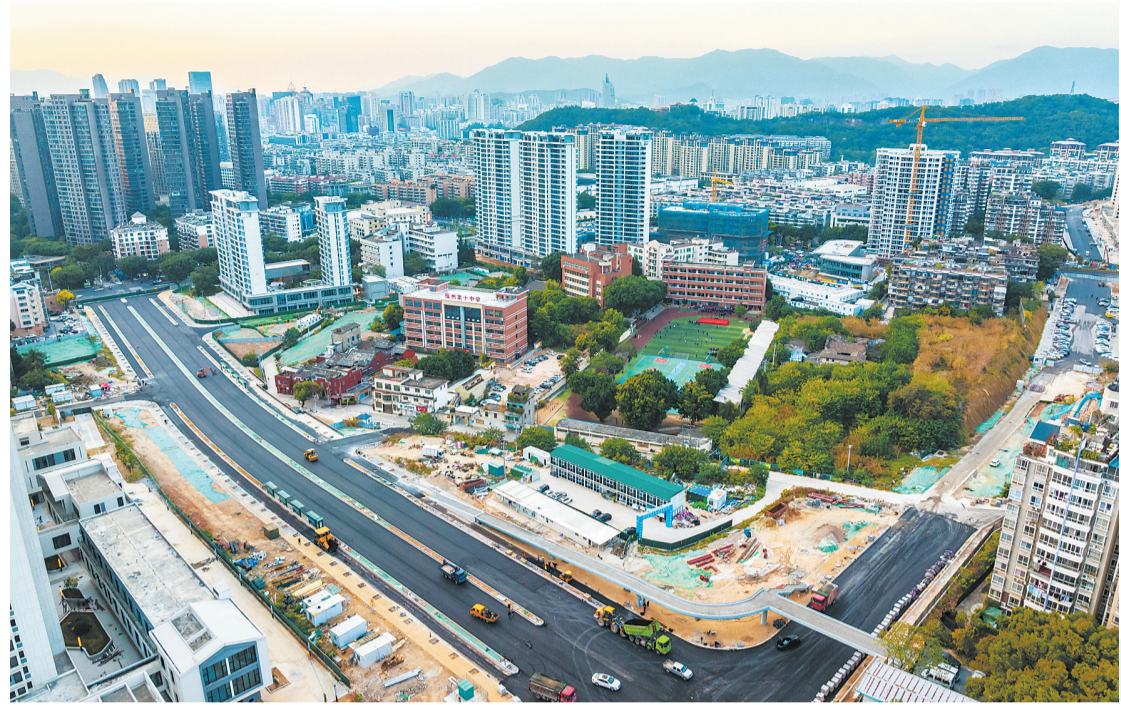
化工路西段道路正在扫尾施工。本报记者 陈暖摄
