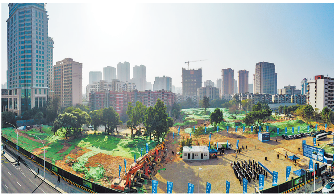
鼓楼区东大新村旧改安置房项目开工。本报记者 池远摄
