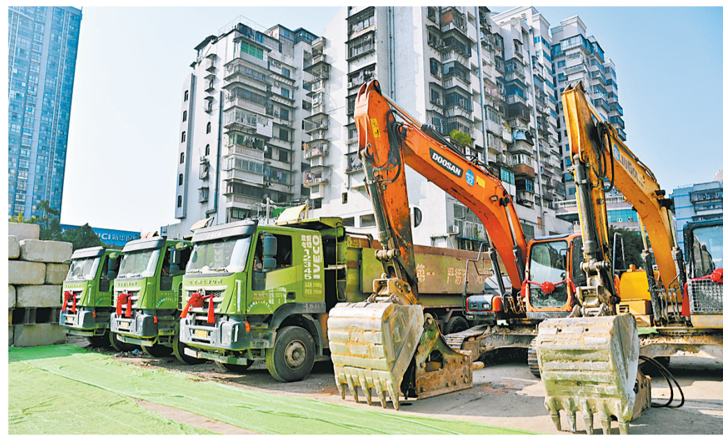
台江区汽车南站周边地块建设项目开工。本报记者 郑帅摄
