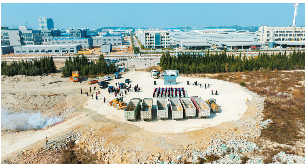
友谊新材料科技工业园四期项目现场。(福清市影像中心供图)
