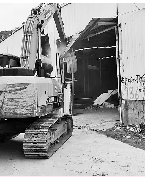
违建被拆除。(闽侯综治办供图)
