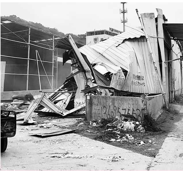
违建拆除后。(闽侯综治办供图)
