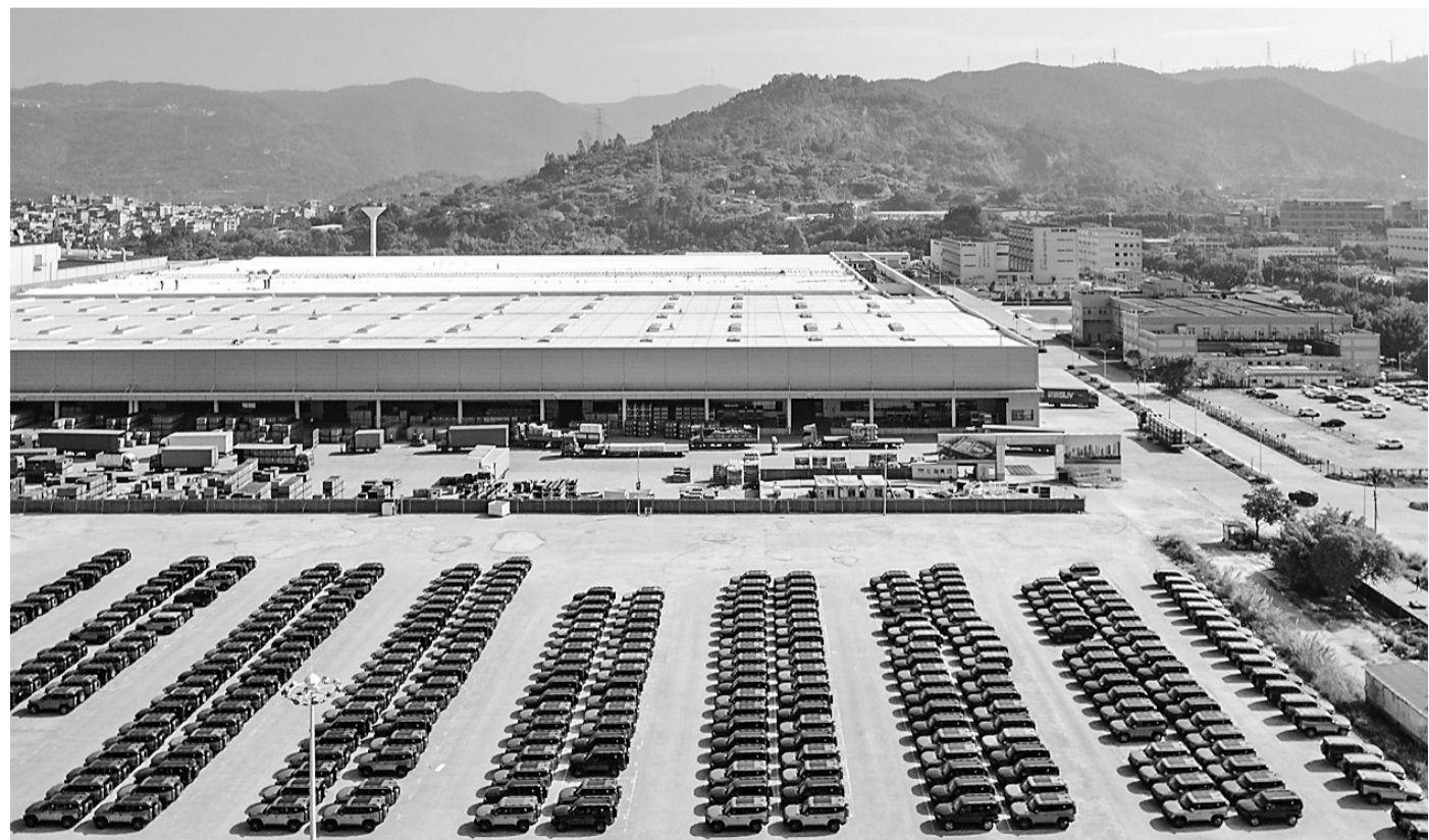
东南汽车产线改造项目投产,一辆辆新车整齐地停放在停车场。本报记者 林双伟 摄
