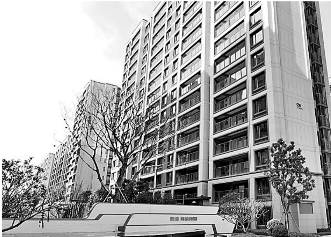
海月龙峰项目B地块楼栋竣工。(市建设局供图)
