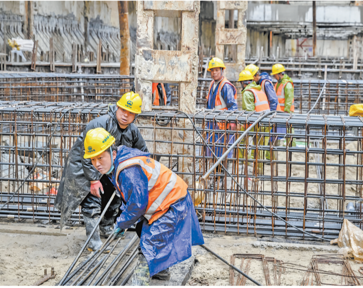
春节期间,机场客运枢纽项目建设者奋战在施工现场。本报记者 陈暖摄
