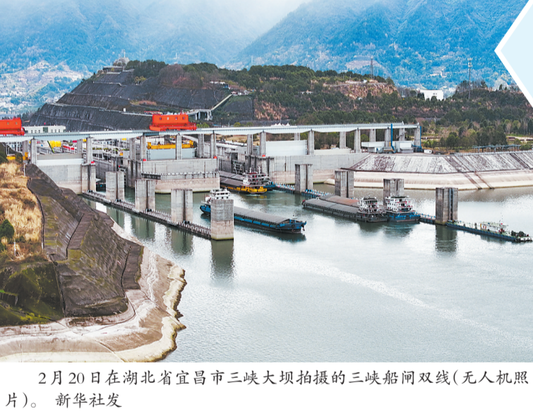
2月20日在湖北省宜昌市三峡大坝拍摄的三峡船闸双闸(无人机照片)。新华社发
