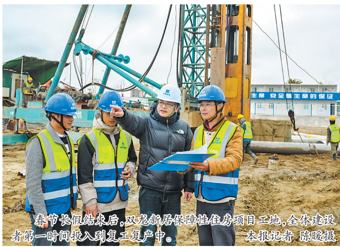
春节长假结束后,双龙新居保障性住房项目工地,全体建设者第一时间投入到复工复产中。本报记者 陈曦摄
