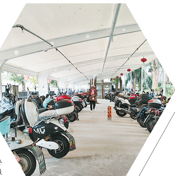
联通小区电动自行车停车棚配备了烟感报警系统、喷淋灭火装置等设施。 本报记者 赖志昌摄
