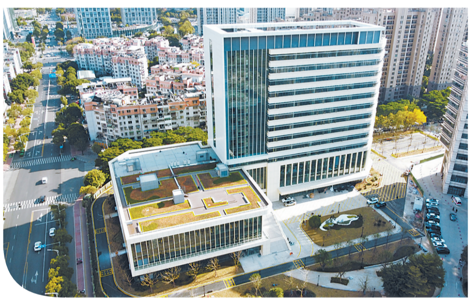
福建省立医院急危重症诊治能力提升专科楼项目。(福建二建集团供图)
