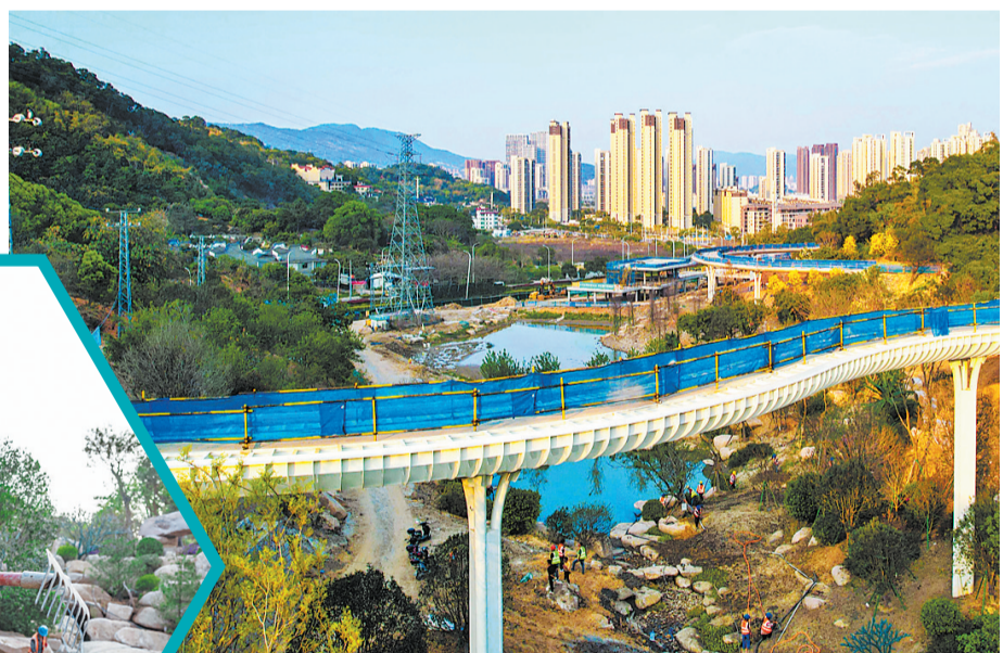
三江口植物园一期项目。本报记者 林双伟摄
