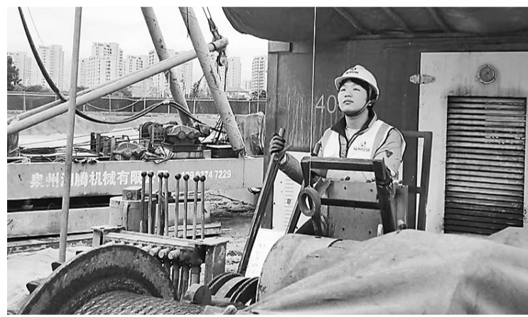
滨海双龙新居项目建设现场。本报记者 赖志昌摄
