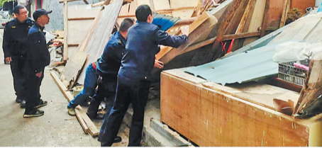
违建小屋被拆除。(晋安城管供图)
