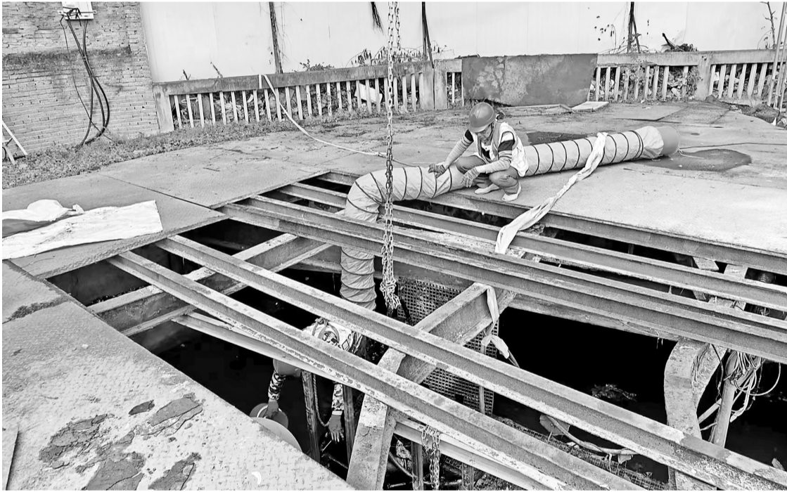
泵站维护工作全面展开。(市城区水系联排联调中心供图)
