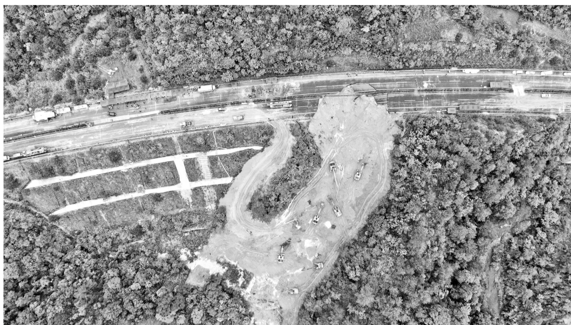
5月2日拍摄的广东梅大高速茶阳路段塌方灾害现场(无人机照片)。新华社记者 王瑞平摄
