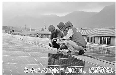
电力工人验收二期项目。陈德钧摄
