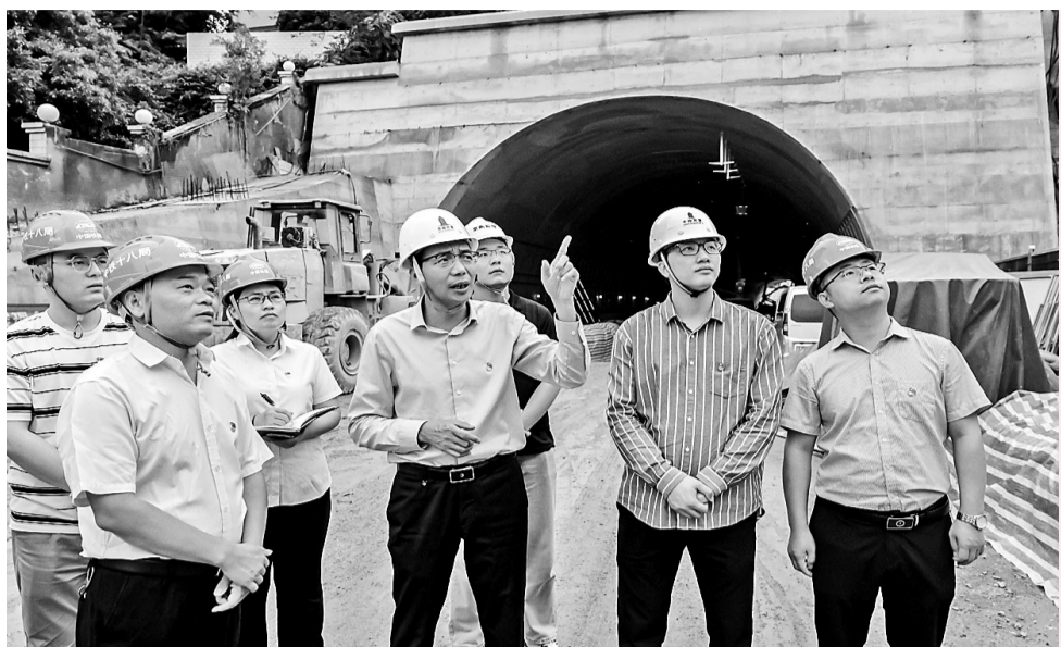
联合党支部成员一起讨论象山隧道明挖段主体结构及附属结构施工方案。本报记者 陈暖摄
