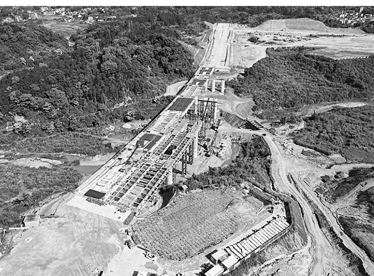
连江鹅头溪大桥施工现场。(连融媒供图)
