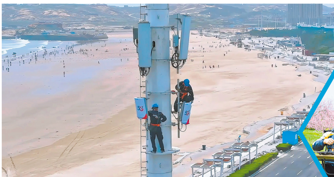
平潭岛5G基站建设现场。
