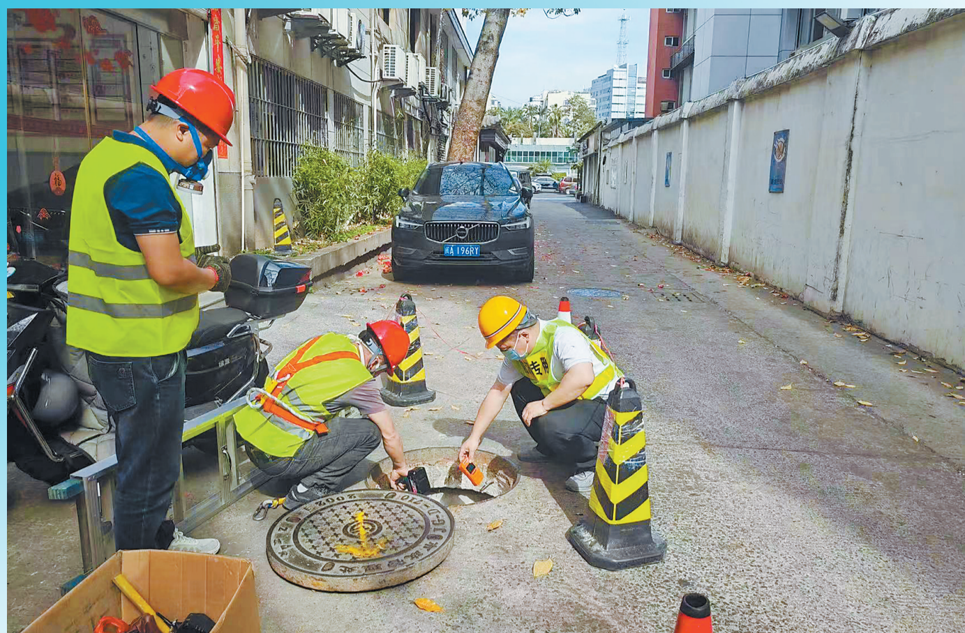
工作人员安装排水设备。
