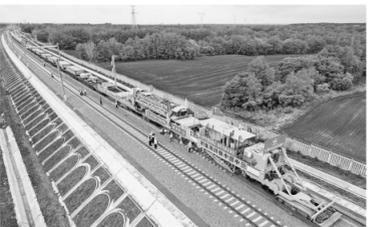
5月28日,中铁四局的工人在铁伊铁路二标段进行铺轨作业(无人机照片)。
