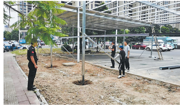
工作人员拆除违建。(闽侯治违办供图)
