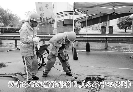
沥青路面坑槽修补项目(公路中心供图)
