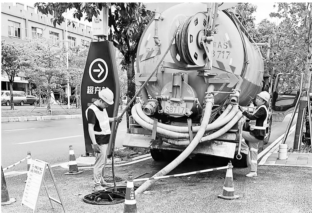
工人对开安路地下排水管道进行疏通。(福州水务集团供图)
