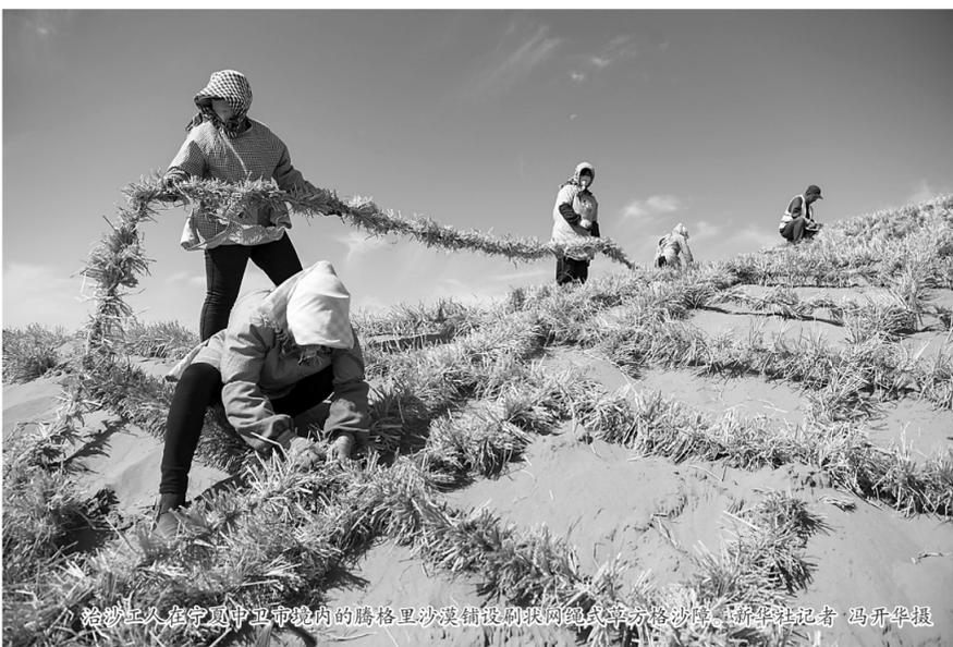
治沙工人在宁夏中卫市境内的腾格里沙漠铺设铁丝网绳式草方格沙障。(新华社记者 冯开华摄)
