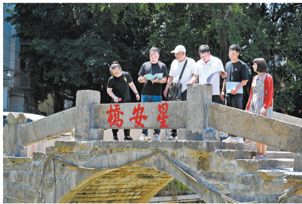
修缮后的星安桥。 本报记者 叶诚摄
