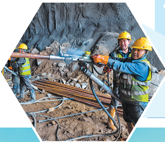
建设者在潭头隧道内施工。本报记者 陈暖摄
