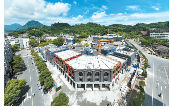
罗源县“文锦街”商业中心项目预计年底竣工验收。
