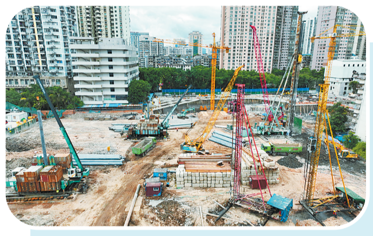
台江区状元小区地块项目呈现一派热火朝天的建设景象。
