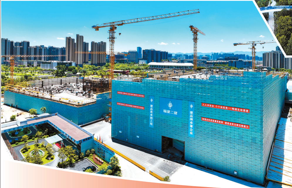
建设中的福州国际人才港。本报记者 林双伟摄
