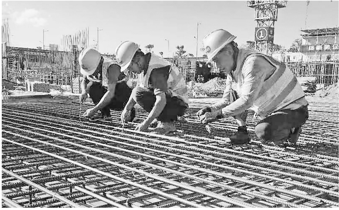
工人在滨海双龙新居项目现场绑扎钢筋。本报记者 赖志昌摄
