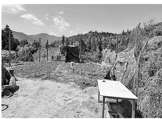
▲违建拆除后。(闽侯治违办供图)
