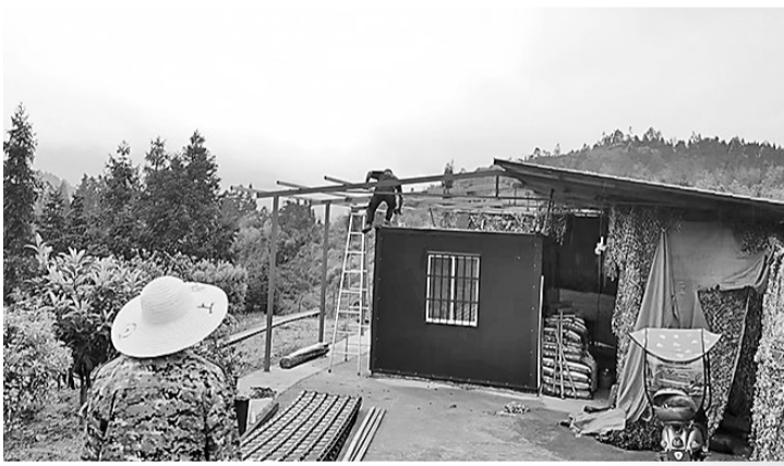
▲违建拆除中。(闽侯治违办供图)
