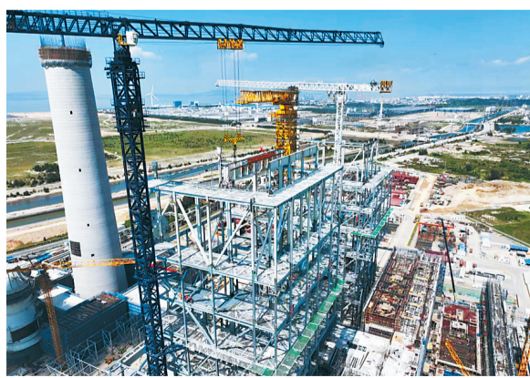
施工现场。(国能福州公司供图)
