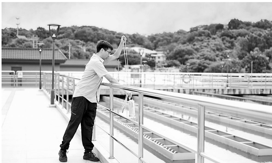
飞凤山水厂工作人员正在巡检。(市自来水公司供图)
