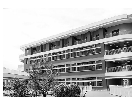
黑龙江大区小学项目现场。(福州高新区供图)
