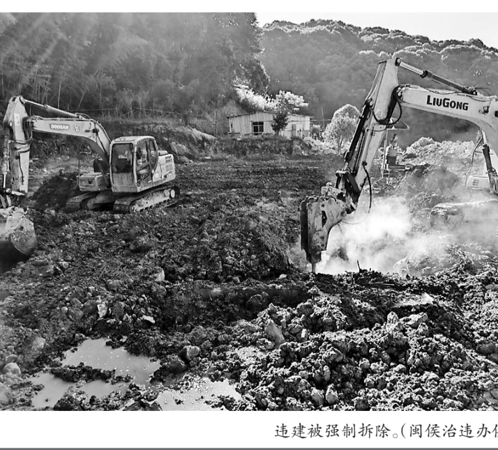
违建被强制拆除。(闽侯治违办供图)
