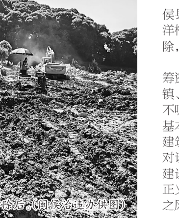
违建拆除后。(闽侯治违办供图)
