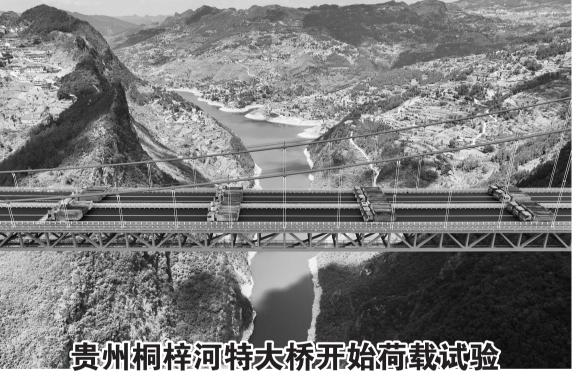
州金(金沙)仁(仁怀)桐(桐梓)高 速桐梓河特大桥开始进行荷载试 验,数十辆大货车按照精密设计的
