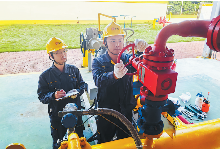
华润燃气工作人员进行开阀操作。(华润燃气供图)
