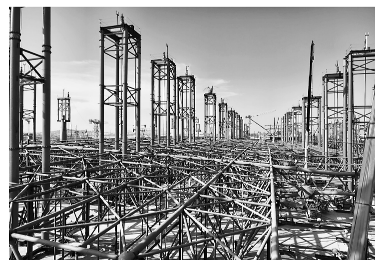
钢屋盖首次提升顺利完成。(项目方供图)
