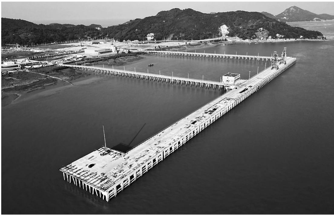
福州(连江)国家远洋渔业基地母港一期项目现场。(连融媒供图)
