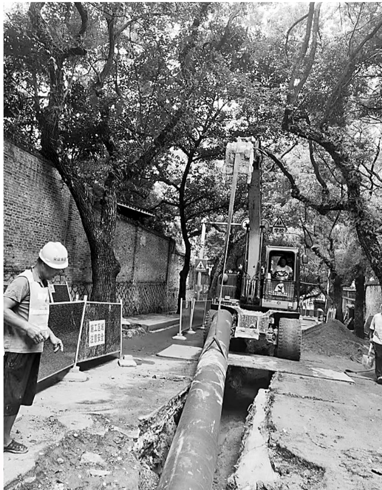
立新路管网施工现场。(市排水公司供图)
